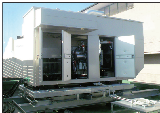
屋外機器用2次元免震装置(sT-GS)
