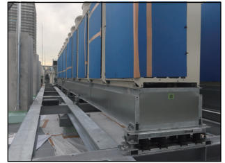
施工例（H鋼基礎）
