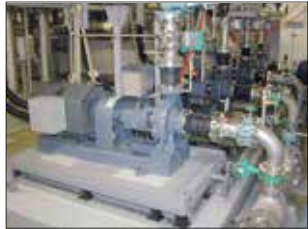
ポンプ用OS式防振装置「PX」
