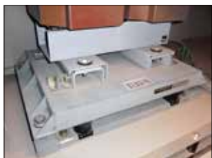
トランス用OS式防振装置「OM-K」
