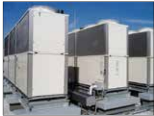
GHP用OS式防振装置「GAS」
