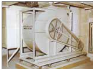
送風機用OS式防振装置「OM-F」
