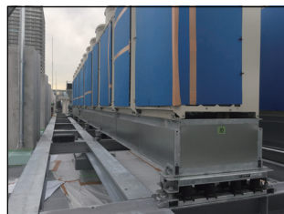
施工例（H鋼基礎）
