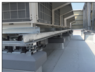
施工例（コンクリート基礎）
