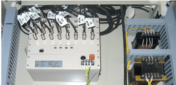
※センサー異常等の自己診断機能を搭載しています。ホストコンピュータからシステムの自己診断も可能です。
